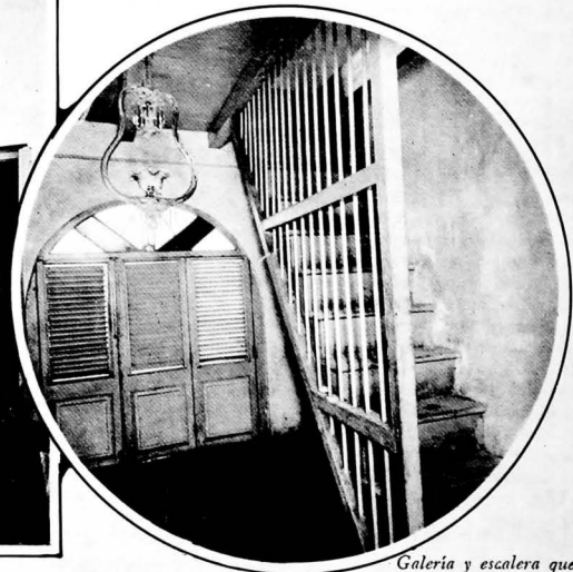
Galería y escalera que conduce a los altos.
